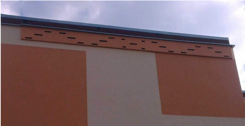
Osadené búdky typu UNI BOX na ulici Horný rad 534/5
