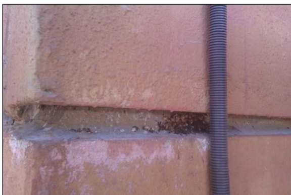
Nezatmelená štrbina s hniezdom dážďovníka, v detaile vidieť trus z predchádzajúcej hniezdnej sezóny
