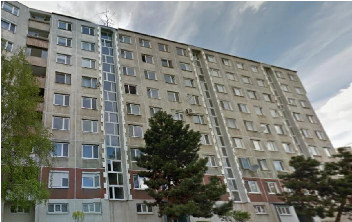
Lubovnianska 10 ešte pred zateplením – všetky štrbiny zatmelené, pod strechou sa nenachádzajú žiadne vetracie otvory – pre hniezdenie vtáctva nevhodný objekt
