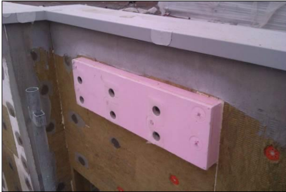
Inštalované APUS 6 v schodiskovej časti
