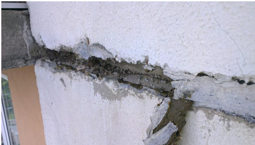
Po odstránení špárovacej hmoty je vidno množstvo trusu v dilatačnej špáre
