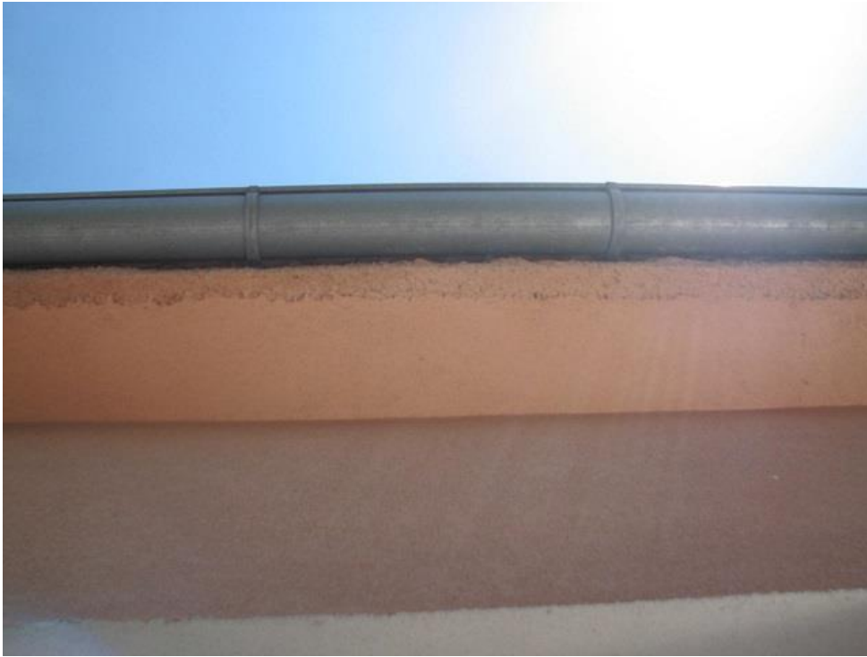
Hniezdo dážďovníka medzi strešným žlabom a krytinou
