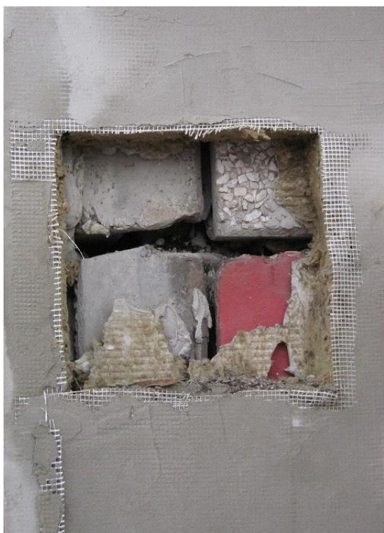
Pripravený výrez na jednej z najvyužívanejších štrbín , vpravo už zapracovaná priechodná búdka MINI B
