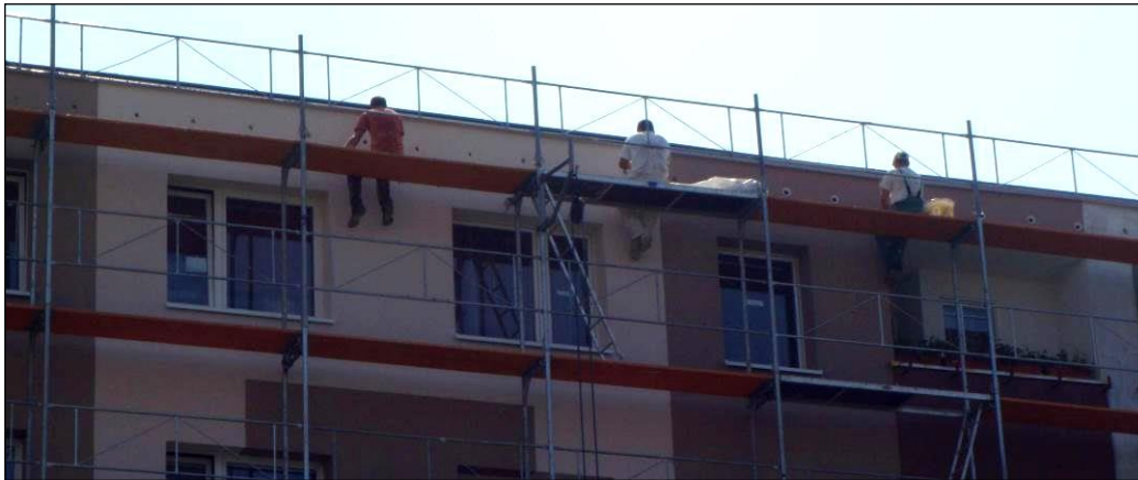
Osádzanie upravených atikových mriežok pracovníkmi stavebnej firmy
