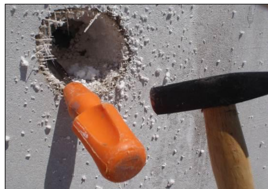
V mnohých prípadoch sa za izolantom nachádza vrstva zaschnutého stavebného lepidla, prekrývajúca samotný vetrací otvor - potrebné manuálne odstrániť
