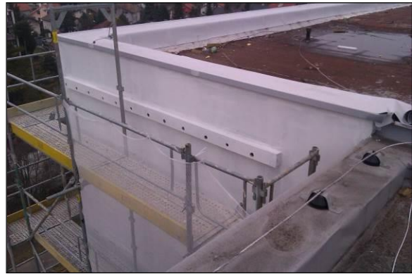
Inštalované APUS 3 na južnej štítovej stene
