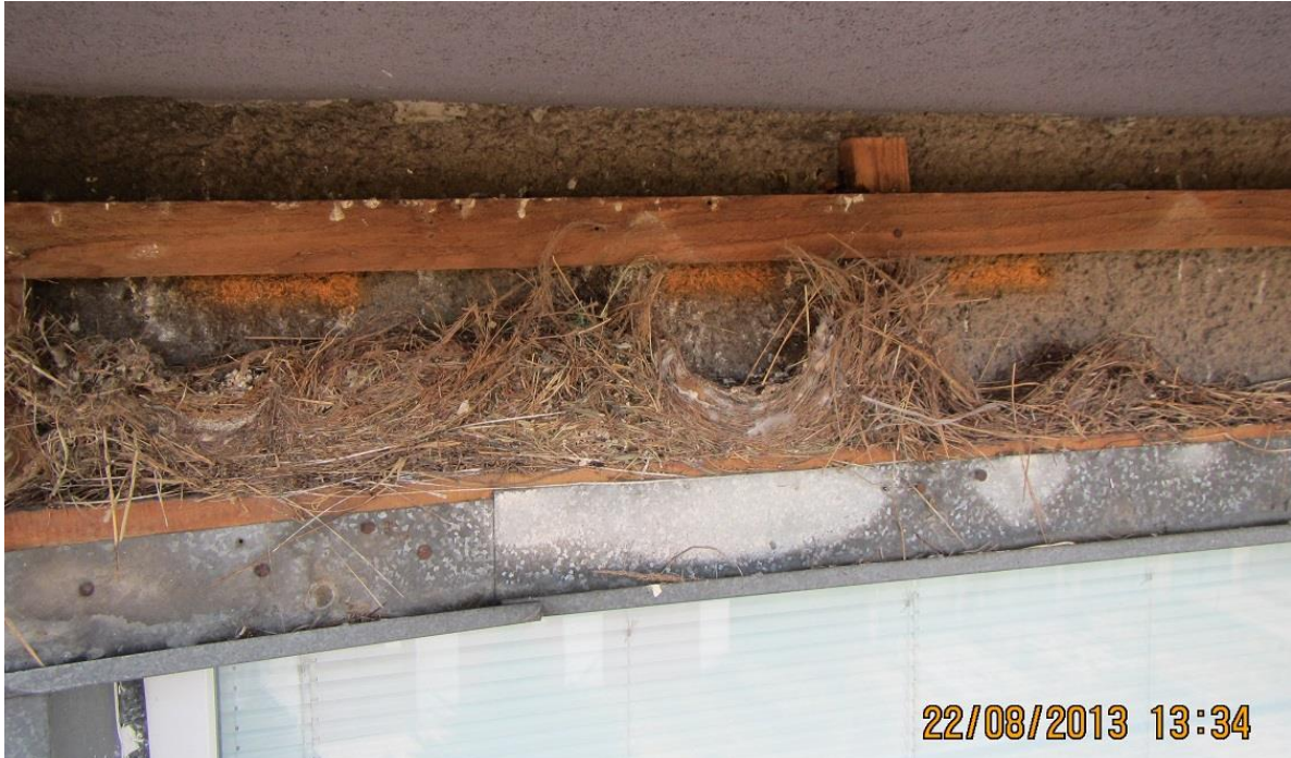
3 hniezda žltochvosta domového v konštrukcii krytiny pod balkónom
