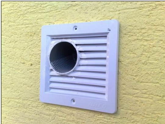
Inštalácia upravených špajzových mriežok so zabudovanou rúrkou ústiaciou do pôvodných vetracích otvorov
