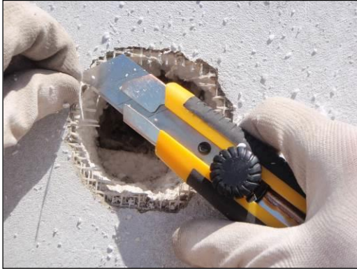
V závere je potrebné odstrániť pretŕčajúcu sieťovinu, ktorá by mohla brániť vo vletu dážďovníkov do vyrezaného vetracieho otvoru
