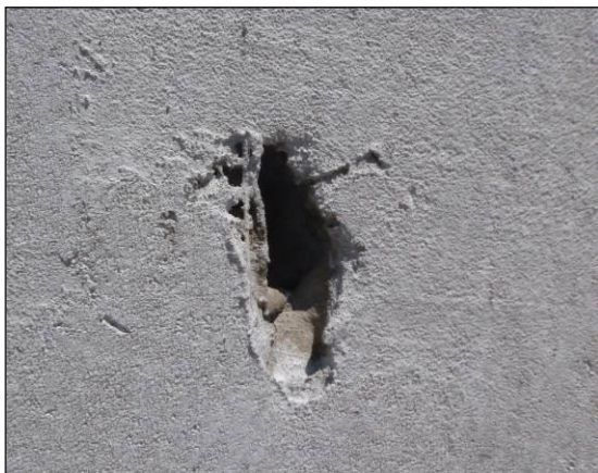
Nedostatočný výrez vetracieho otvoru v zateplení, cez ktorý sa dážďovníky nedostanú – priemer 2 cm
