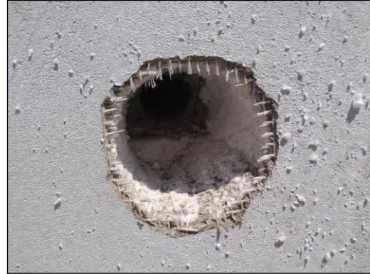
Výrez po dokončení, umožňujúci vlet dážďovníkov do vetracích otvorov atiky
