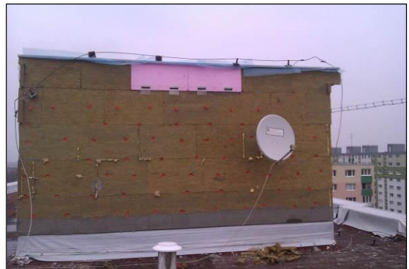
Inštalované MAXI-B na výťahovej šachte
