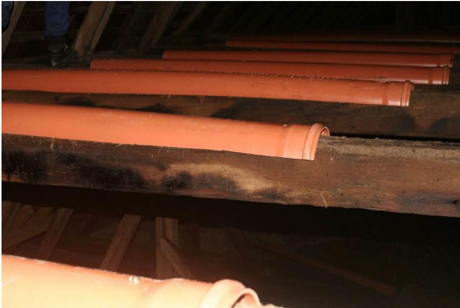
Detail osadenia jednotlivých ochranných krytov na klieštiny
