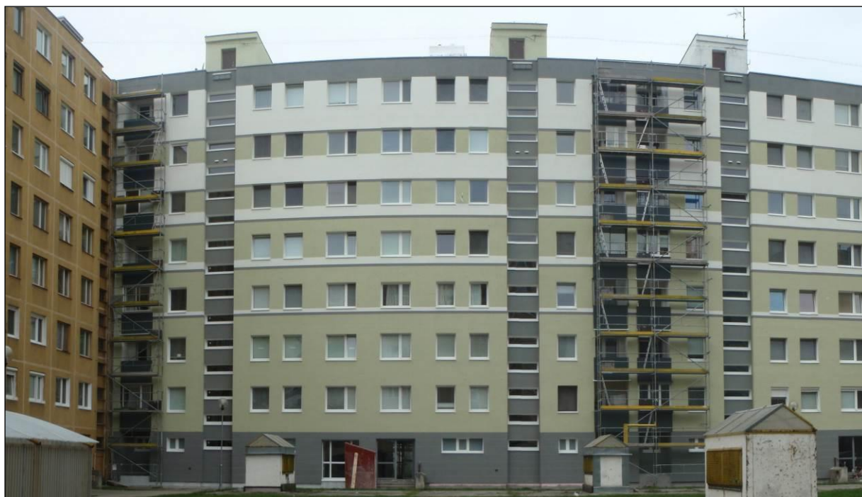
Celkový pohľad na dom v záverečnej fáze prác – 19.4.2013
