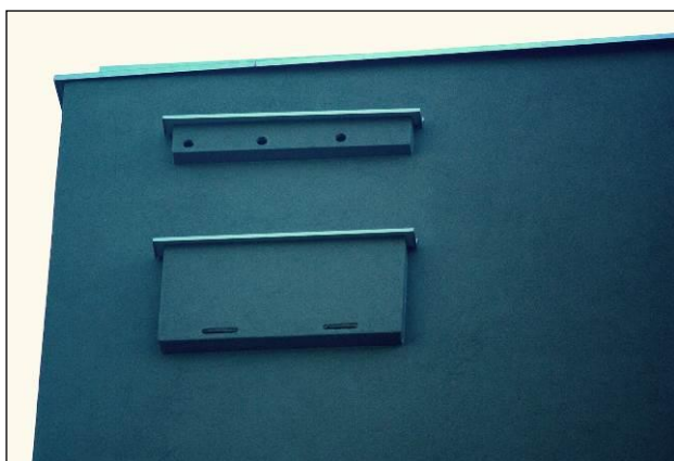
Detail na inštalované búdky
