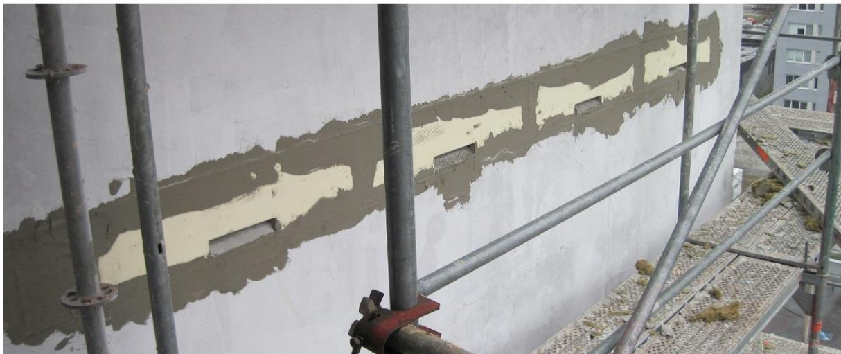
Pripravený výrez na upravenej štrbine, pod ňou už inštalované APUS priechnodné.
