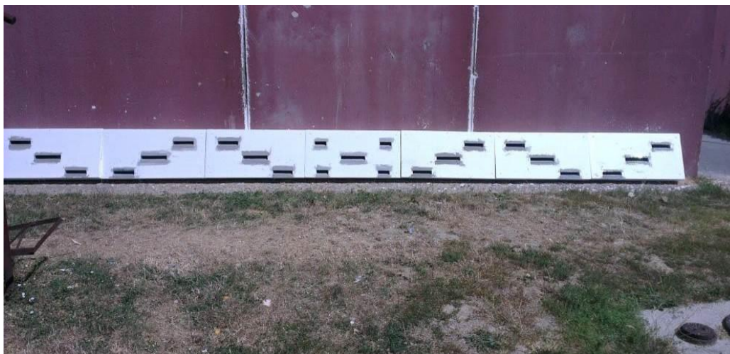
7 búdok nového typu - UNI BOX pripravených na inštaláciu do zateplenia
