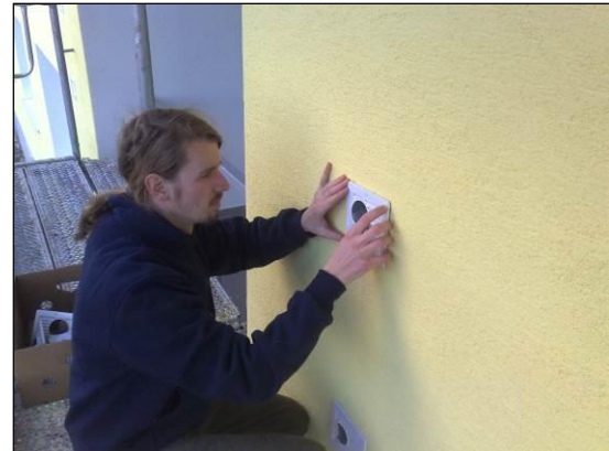
Inštalácia upravených špajzových mriežok so zabudovanou rúrkou ústiaciou do pôvodných vetracích otvorov
