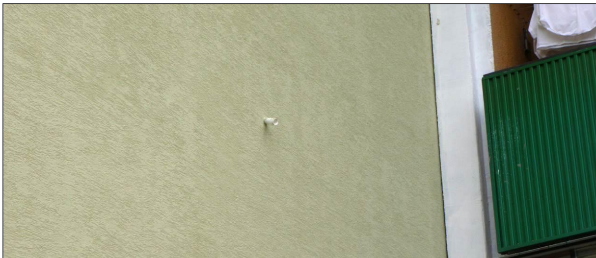
Detail na ponechané výpustné rúrky po demontáži lešenia
