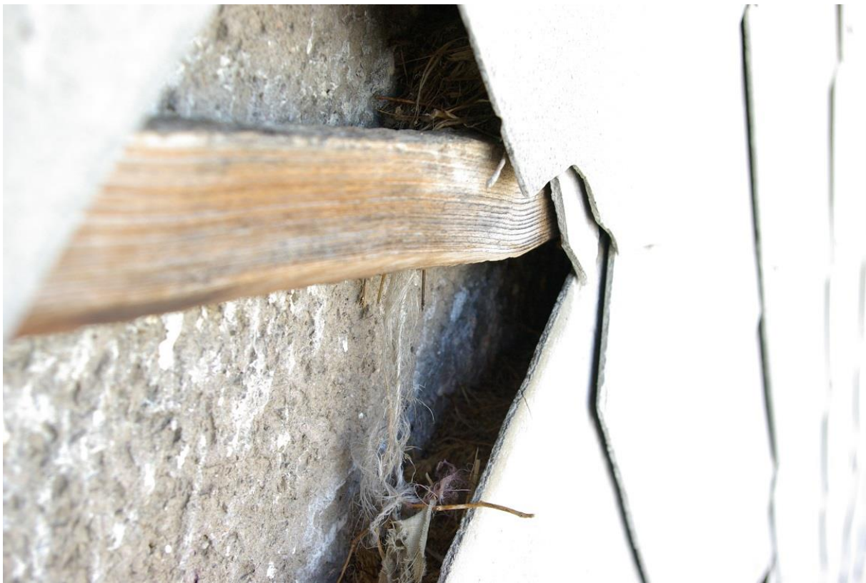
Dve hniezda dážďovníka pod sebou na konštrukcii krytiny
