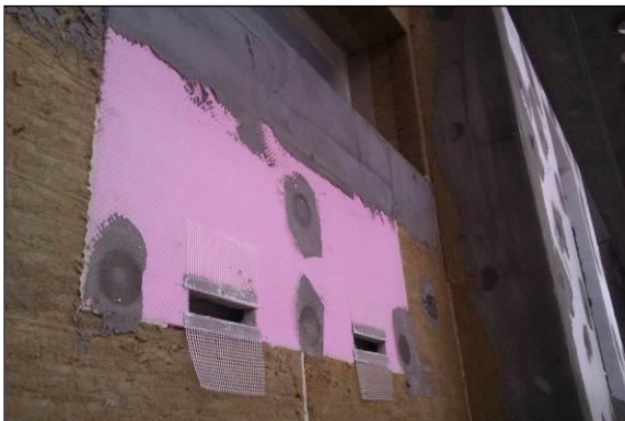
Inštalované MAXI-B v schodiskovej časti
