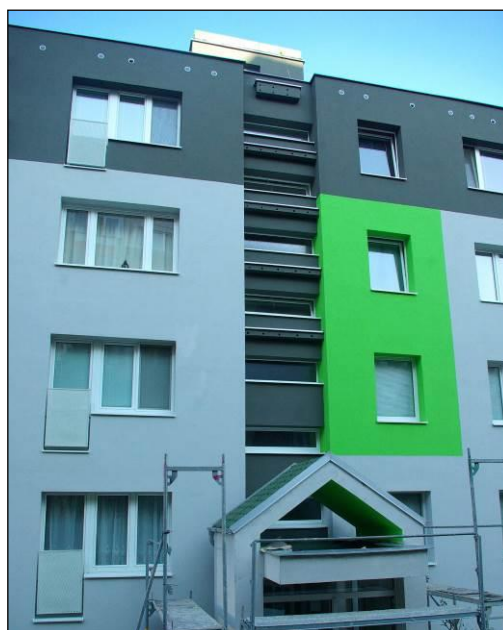
Vytvorená „hniezda stena“ na severnej štítovej stene s vyššiou koncentráciou búdok rôznych typov
