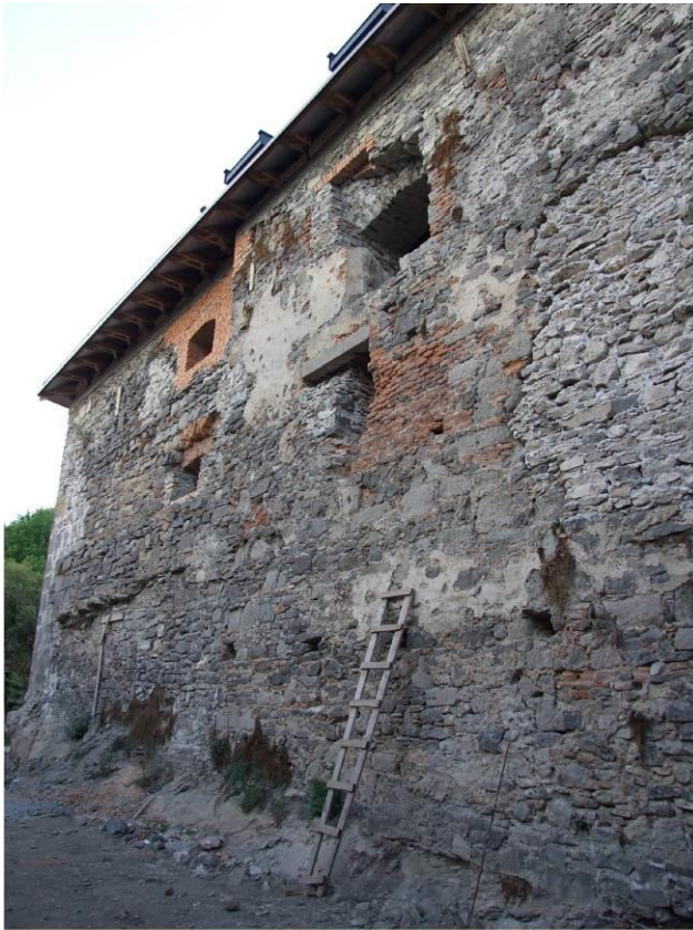
fasáda pred rekonštrukciou
