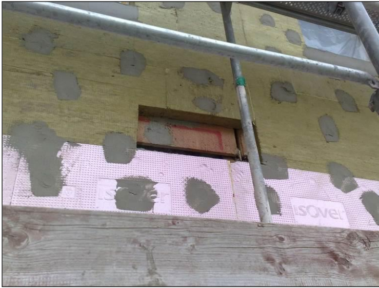
Ponechané výrezy v zateplovacej vrstve zabezpečujúce prístup dážďovníkov k hniezdam
