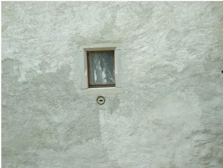
fasáda s vynechanými hniezdnymi dutinami po rekonštrukcii
