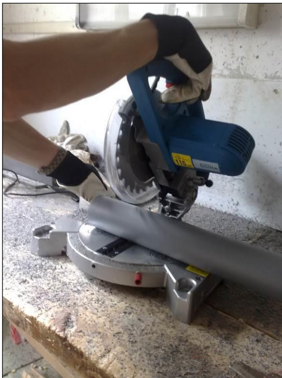
Pílenie PVC rúrok na potrebnú šírku
