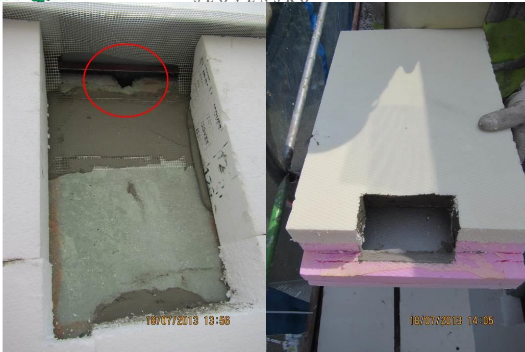
Prípravený výrez na jednej z využívaných štrbín , vpravo prípravená priechodná búdka MINI B
