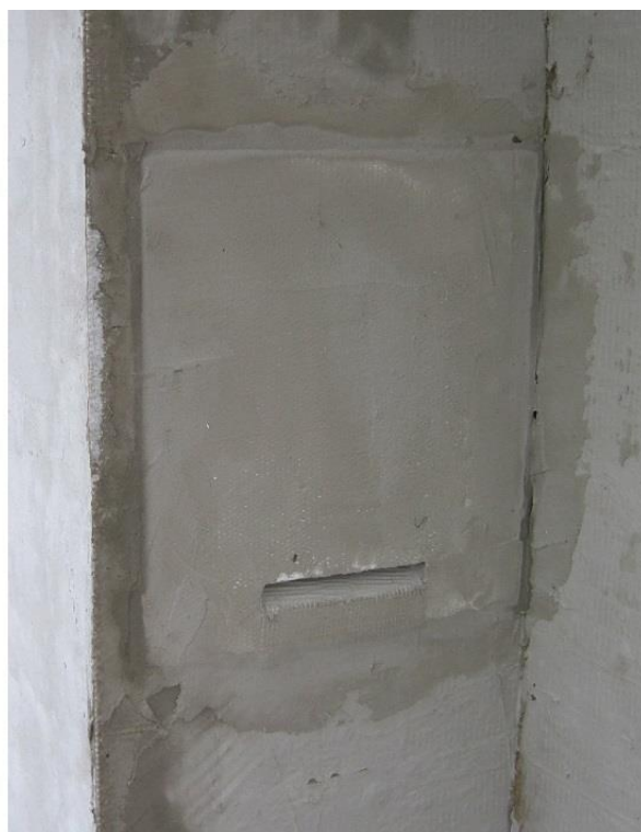
Pripravený výrez na jednej z najvyužívanejších štrbín , vpravo už zapracovaná priechodná búdka MINI B
