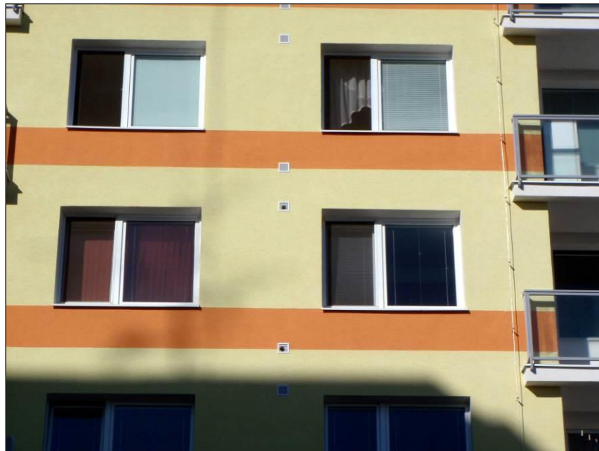
Inštalácia upravených špajzových mriežok so zabudovanou rúrkou ústiaciou do pôvodných vetracích otvorov
