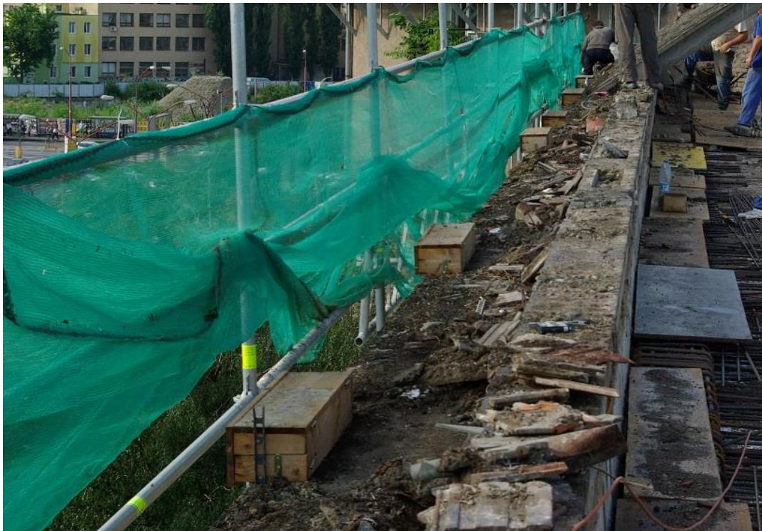
Osadené dočasné búbky (vlet odspodu) na miestach presnej polohy pôvodných hniezd
